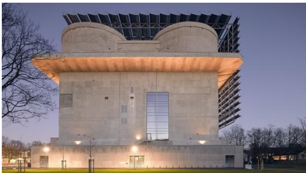
Рис. 4. – Hamburg energy bunker, Гамбург
