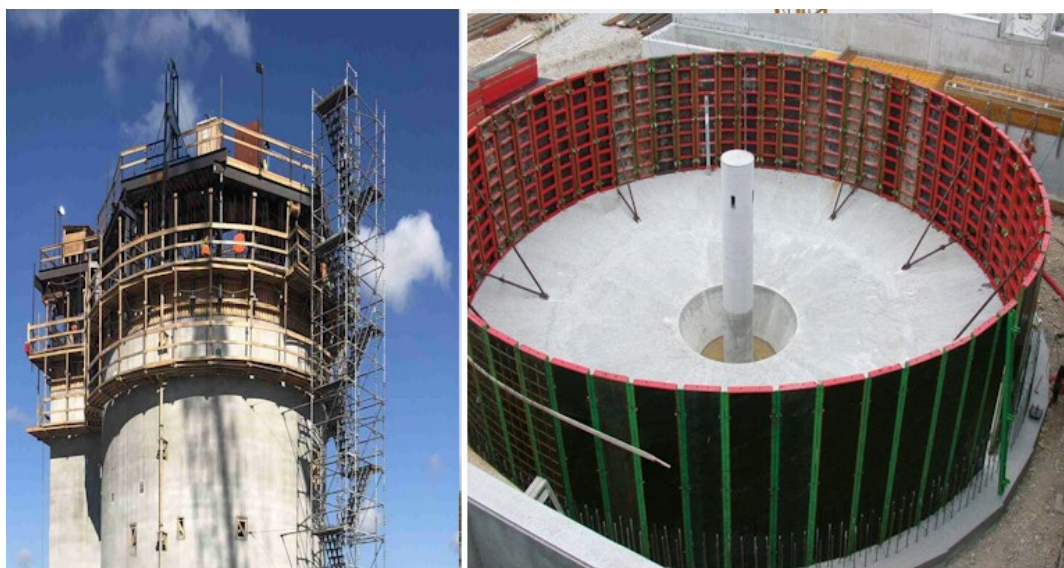
б — крупнощитовая опалубка
