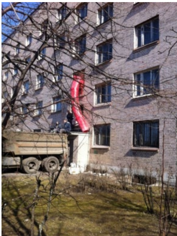
Рис. 5. – Мусоросброс для выгрузки мусора из 5-этажного здания общежития №7 СПбГАУ
