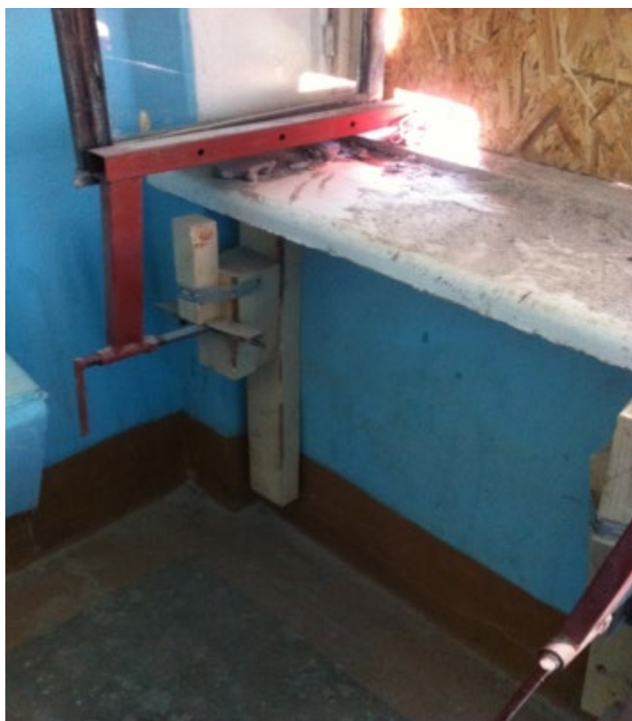
Рис. 3. – П-образное крепление мусоросброса в оконном проеме Допустимая масса выбрасываемого груза до 15 кг. Схема мусоросброса с гасителем представлена на рисунке 4.
