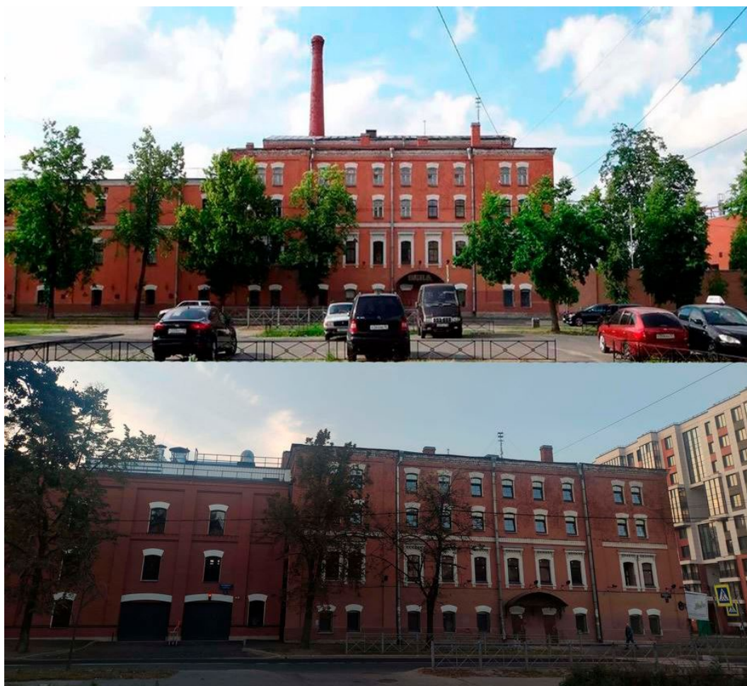
Рис.7. Фотографии фасада здания административного корпуса 2019 и 2025 годов.
