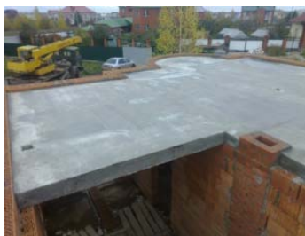
Рис. 2. - Монолитная плита перекрытия
